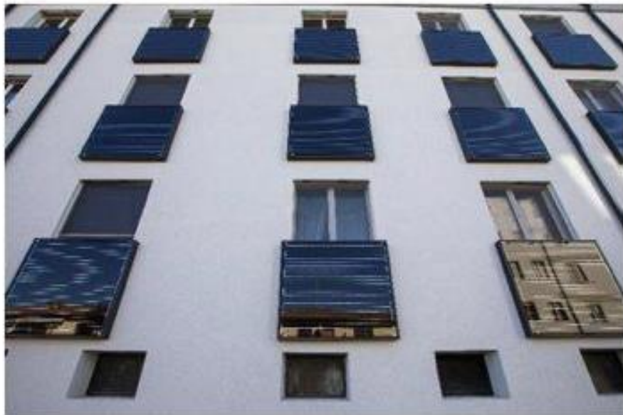
Figura 1 e 2: Blocco finestra che integra moduli fotovoltaici verticali in facciata e sistemi di ombreggiatura automatica adattiva. Edificio caso studio del progetto EnergyMatching a Campi Besenno (FI). Credits:
