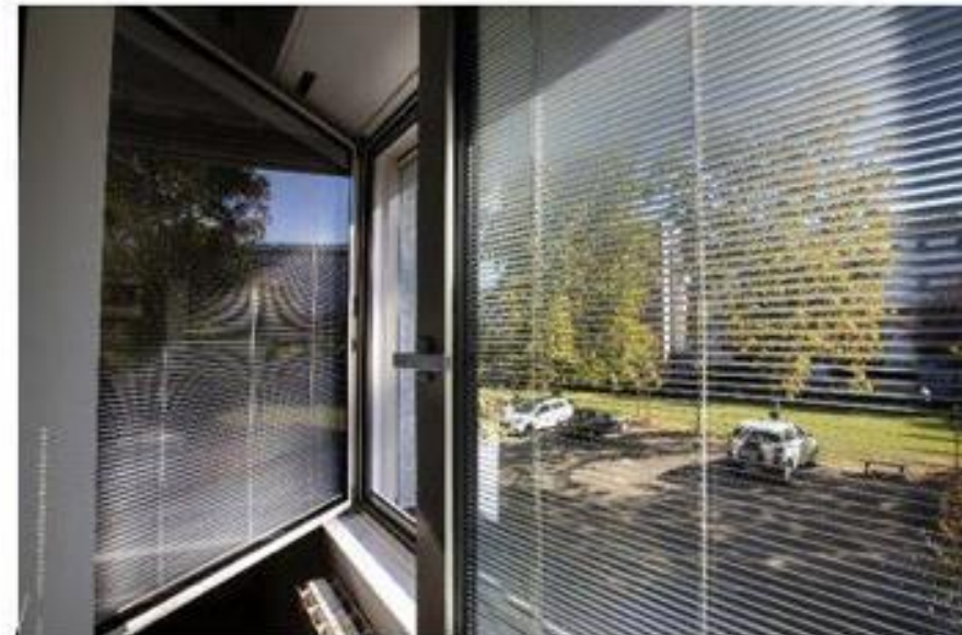
Figura 1 e 2: Blocco finestra che integra moduli fotovoltaici verticali in facciata e sistemi di ombreggiatura automatica adattiva. Edificio caso studio del progetto EnergyMatching a Campi Besenno (FI). Credits:
